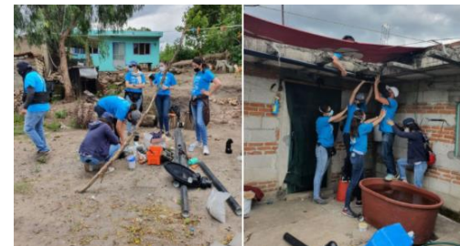
Instalación de dos Sistemas de Captación de Agua de Lluvia (SCALL) con TECHO Puebla (septiembre 2021)
