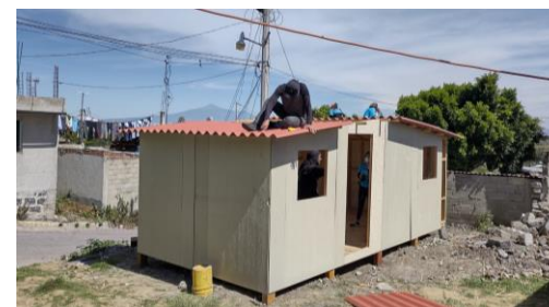
Construcción de casas de emergencia con TECHO Puebla (octubre 2021)
